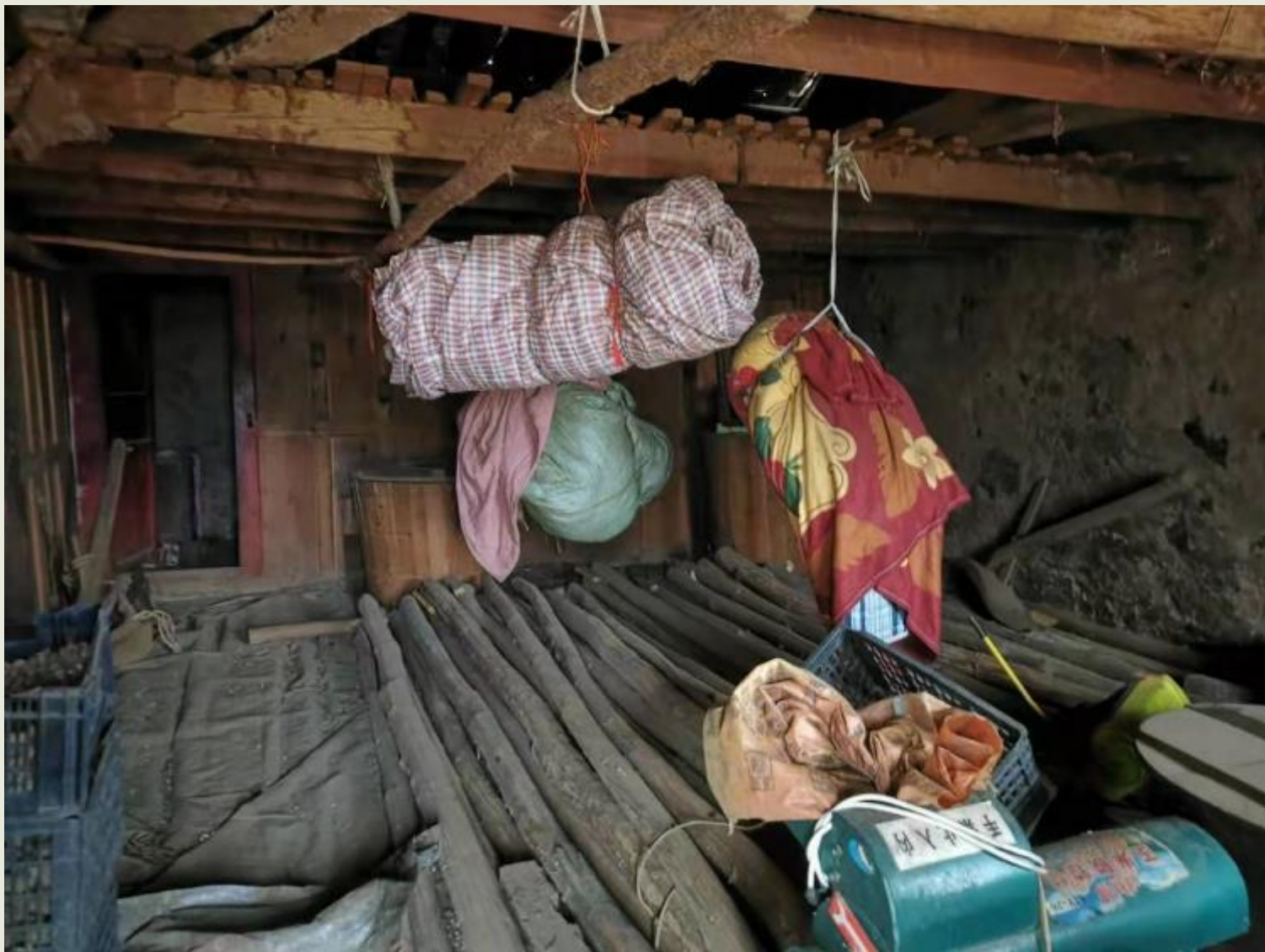
二層用來堆放雜物和糧食，並沒有固定的樓梯。 可能也正因為不方便上下，所以使用率不高、積灰很厚。
